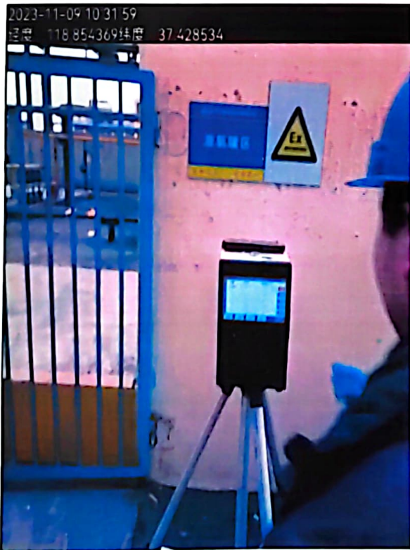
液氨储罐周围上风向
